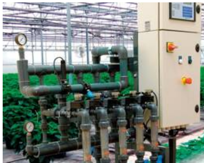
▲ Banco di fertirrigazione all'esterno della centrale irrigua.
